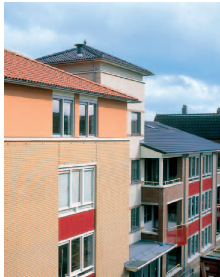
Зграде у Холандији направљене од префабрикованих бетонских елемената. Бетонске кровне плоче коришћене у завршним кровним радовима обезбеђују дуг употребни век зграде. Уз дозволу компаније BFBN.
