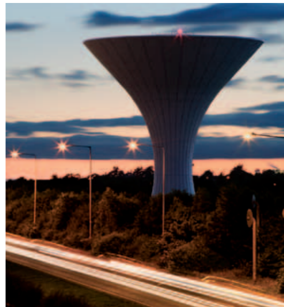
Пример водоторња Силог (Sillogue), уз дозволу компаније P.H. Mc Carthy Engineers, Даблин, Ирска.
