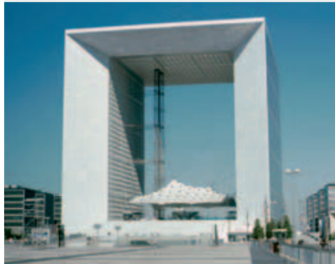
Велики лук (La Grande Arche), Париз. Архитекта: Јохан Ото фон Шпрекслен (Johann Otto von Spreckelsen); систем градње: облагање мермером; довршио Пол Андро (Paul Andreau). Уз дозволу компаније Concrete Centre.
