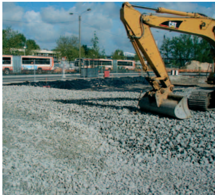
Поновно искоришћен отпадни материјал и дробљени отпад од бетона могу се користити у изградњи путева. Захваљујемо: Фототеци француског центра за истраживање и проучавање бетонске индустрије CERIB.
