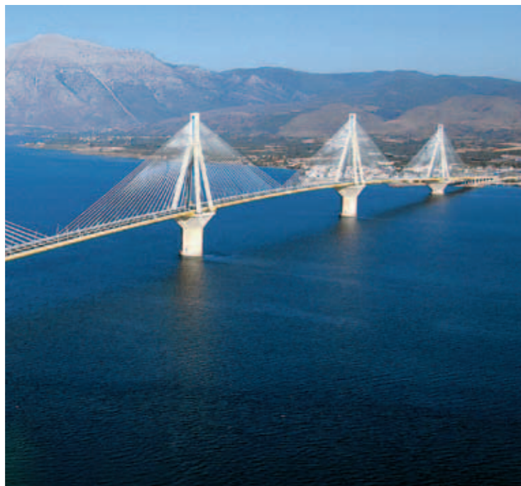
Висећи мост Рион Антерион у Грчкој представља конструкцију која захтева дуг употребни век. Мост је дугачак 3 км, а централни распан износи 560 м. Уз дозволу FIB.
