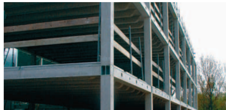
Монтажно-демонтажни скелет зграде у Холандији. Уз дозволу компаније BFBN.
