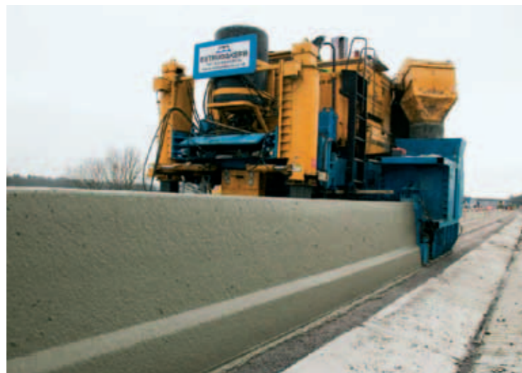
Бетонске заштитне ограде данас се користе на свим аутопутевима у Великој Британији. Пројектоване су тако да достигну експлоатациони век од 50 година без суштинског одржавања. Уз дозволу британског удружења Britrave.
