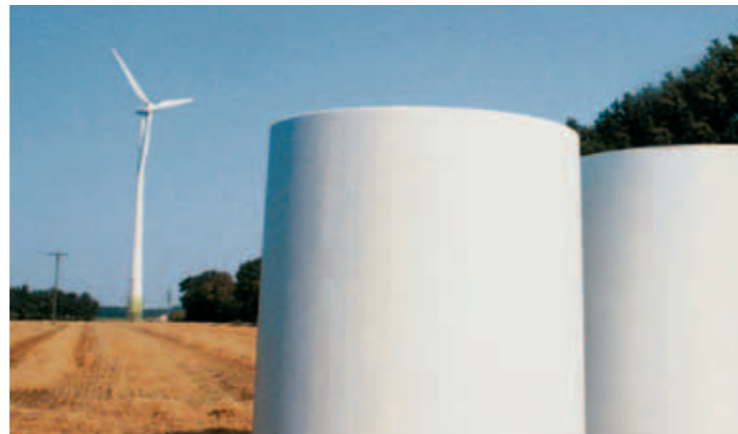
Префабриковани бетон често се користи за турбине ветрењача – његов висок степен отпорности на временске утицаје и својствена крутост омогућава стабилну и отпорну конструкцију која ствара електричну енергију, као обновљиви извор енергије. Уз дозволу удружења British Precast.
