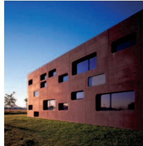
Графичке бетонске технике пружају додатни потенцијал у избору фасада. Фасадни зид у Немачкој. Ауторска права: Одељење маркетинга Betonmarketing Süd, 2004. године (фотографија: Гвидо Ербринг (Guido Erbring)).
